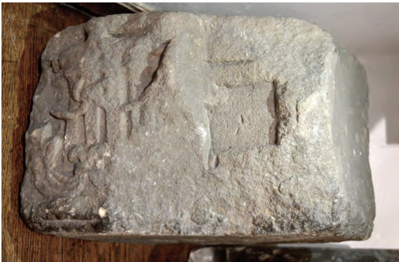
Il. 7. Fragment gzymsu wieńczącego, pochodzący z czasów XVI-wiecznej przebudowy, Zamek w Kórniku. Fot. Witold Miedziak
