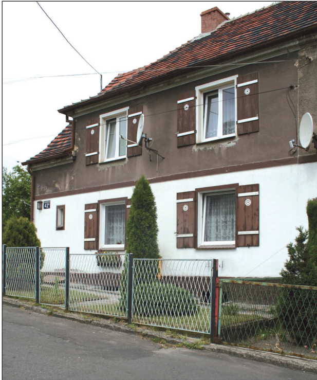
15. Osiedle na Gaju w Wałbrzychu. Budynek typowy „Schlesische Heimstätte” w północnej części osiedla przy ul. Bolesława Krzywoustego. Fot. Autorka
