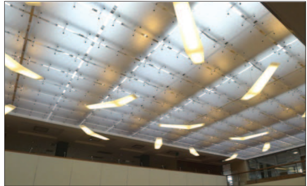
21. Perforowany sufit podwieszany. Panele rozpraszające światło i dźwięk zastosowane w czytelni głównej. PPiP 2010–2012 r. Fot. własne
