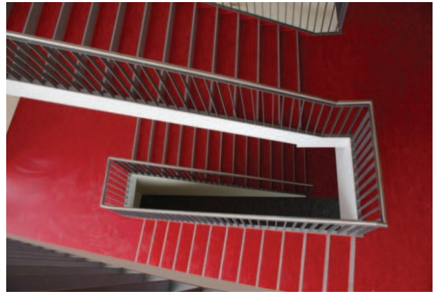
20. Klatka schodowa wykończona czerwonym linoleum. PPiP 2010–2012 r. Fot. własne 20. Staircase is finished with red linoleum. PPiP 2010–2012. Private photo
