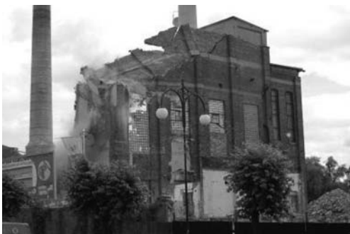
Fot. 3. Fabryka Kwasku Cytrynowego (największy obiekt kubaturowy) w trakcie wyburzania
