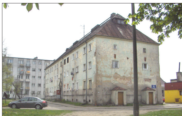
26. Budynek mieszkalny pracowników d. cukrowni z lat 80. XIX wieku – widok z 2010 r. (ul. Narutowicza ob. 75).
