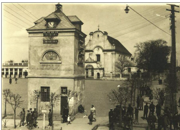
8. Stacja transformatorowa z zegarem wybudowana w 1929 r. na osi ul. Narutowicza, widok z lat 30. XX wieku. Zbiory archiwalne MG Biblioteki Publicznej w Żychlinie 8. Transformer station with a clock erected in 1929 on the axis of Narutowicza Street before it joins 29 Listopada Square (former Market Square) – in the 1930s. Archival resources MG of the Public Library in Żychlin
