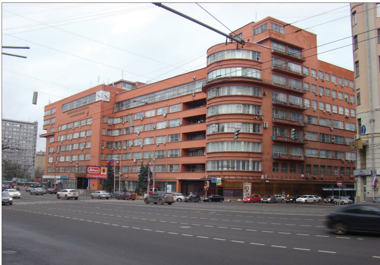
6. Wczesny modernizm (konstruktywizm) – Budynek Ministerstwa Rolnictwa według projektu A. Szczusjewa [Здание Наркомзема А. Щусева], 1928–1933, Moskwa. Źródło: zbiory własne autora 6. Early modernism (constructivism) – the Ministry of Agriculture building, design by: A. Shchusev [Здание Наркомзема А. Щусева] 1928–1933. Source: author's private collection
