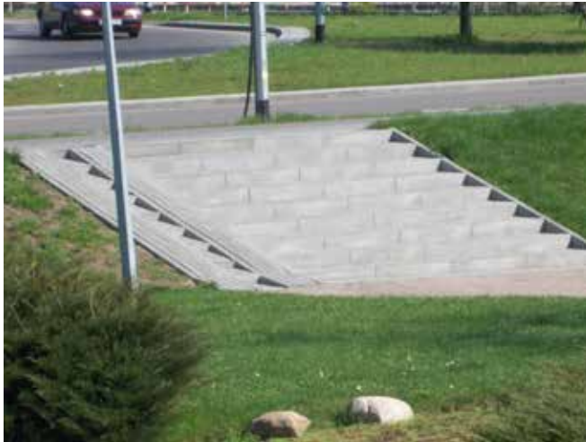
Fot. 2. Wciąż powszechnie spotykane nienormatywne podjazdy w ciągach biegów schodów terenowych
