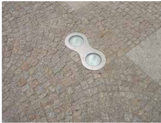
Fot. 1. Montowane w posadzce przestrzeni publicznych silne źródła światła są utrapieniem szczególnie osób z dysfunkcjami wzroku, ale także innych użytkowników przestrzeni publicznych
