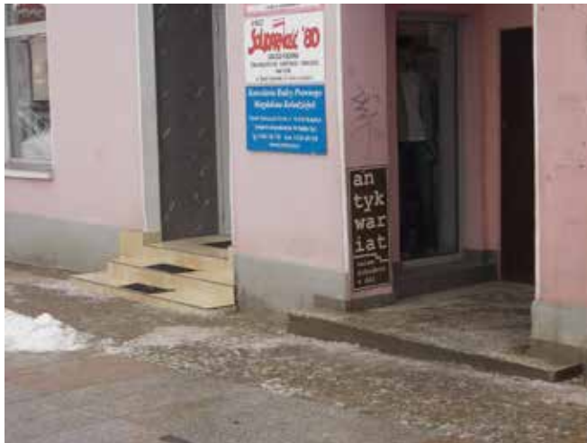
Fot. 5. Przykłady barier architektonicznych pozostawionych mimo przeprowadzonej gruntownej modernizacji Rynku Kościuszki w Białymstoku
