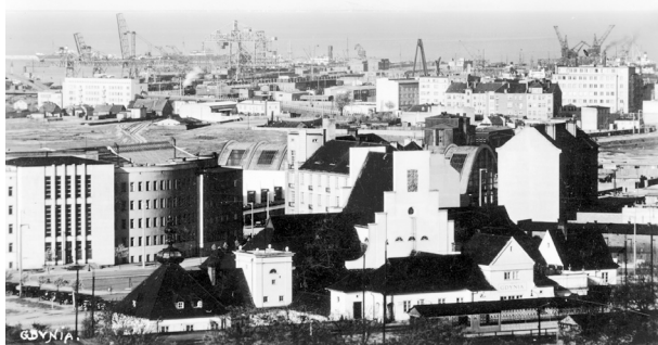
Fot. 8. W drugiej połowie lat 30. XX w., śródmieście Gdyni w swoim wizerunku miało już w pełni wielkomiejski charakter, czego dowodem jest pocztówkowa panorama miasta i portu w widoku od strony dworca kolejowego z 1938 r.
