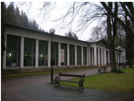
Ryc. 3. Hala spacerowa w Dusznikach-Zdroju, (fot. M. Piróg)
