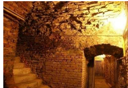
Ryc. 13. Piwnica, część D, widok na ścianę wschodnią. Fot. K. Janus
