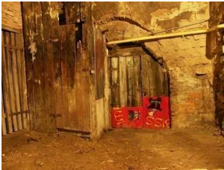
Ryc. 10. Piwnica, część B, przejście do części C. Fot. K. Janus
