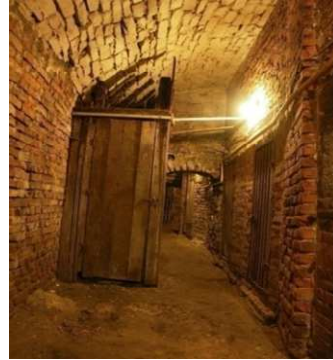
Ryc. 9. Piwnica, część F, widok na ścianę wschodnią. Fot. K. Janus
