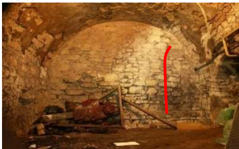
Ryc. 12. Piwnica, część C, widok na ścianę wschodnią z zaznaczeniem zamurowanego otworu. Fot. K. Janus
