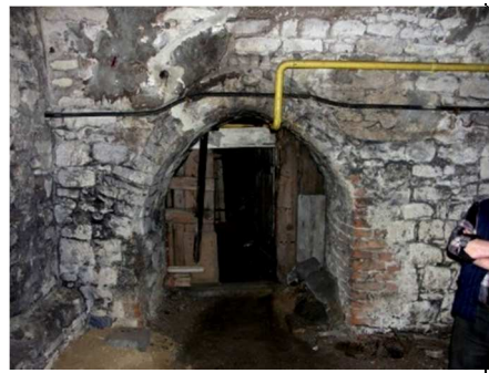
Ryc. 11. Piwnica, część C, przejście do części B. Fot. K. Janus
