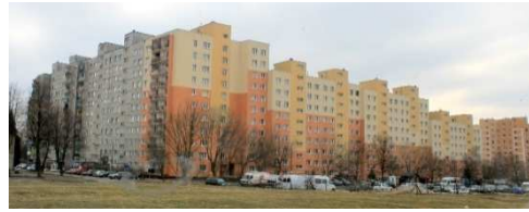
Ryc.14. Harnasie 21/Zakopiańska 1. Budynek prefabrykowany z 1986r. po ociepleniu w latach 90. i częściowej wymianie stolarki okiennej. Widok ogólny od strony północno-wschodniej
