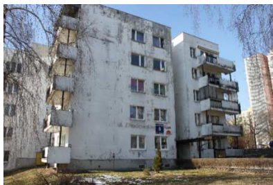
Ryc.6. Noskowskiego 8. Budynek prefabrykowany z 1980r. po ociepleniu w latach 90. i częściowej wymianie stolarki okiennej Fig. 6. A block at Noskowskiego 8. The building of nineteen-eighties – insulated in nineteen-nineties,, with windows partially replaced
