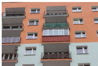
Ryc.21. Fragment elewacji zachodniej po II etapie ocieplenia. Widok zabudowy loggi cofniętej, patrz termogram ryc.22 Fig. 21. West elevation after second stage of thermal insulation – recessed loggias
