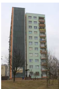
Ryc.20. Króla Rogera 6. Budynek prefabrykowany z 1986r. po ociepleniu w latach 90. i częściowej wymianie stolarki okiennej. Widok ogólny od strony północno-wschodniej Widok ogólny od strony południowej Fig. 20. Building at Krola Rogera 6, erected in 1986. Insulated in nineteen-nineties, with windows partially replaced. South-east view.
