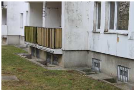
Ryc.3. Harnasie 3. Fragment budynku prefabrykowanego z 1980r. po ociepleniu w latach 90. i częściowej wymianie stolarki okiennej Fig. 3. Precast panel block of flats of nineteen-eighties – insulated in nineteen-nineties, with windows partially replaced
