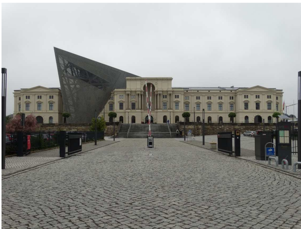
Ryc. 1. Daniel Libeskind, Muzeum Bundeswehry, Drezno, Niemcy – Źródło: Aleksander Serafin Fig. 1. Daniel Libeskind, Bundeswehr Museum, Dresden, Germany – Source: Aleksander Serafin
