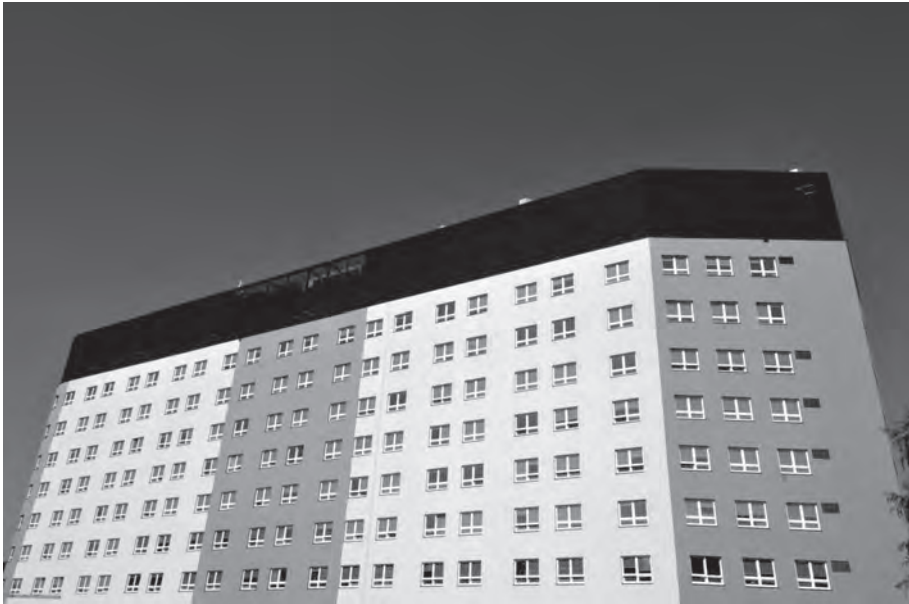
Fot. 10. Olbrzymia, ciężka bryła budynku o jaskrawych: żółtych i pomarańczowych barwach, stanowiąca rażąco dominancę dla znacznego obszaru miasta, w ogólnopolskim internetowym plebiscycie uzyskała tytuł „Makabryły roku 2015”
