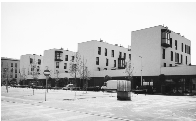
Fot. 1. Nowe Żerniki, centralna przestrzeń publiczna, miejsce na bazar i usługowe partery w tle. Inwestycja w trakcie budowy
