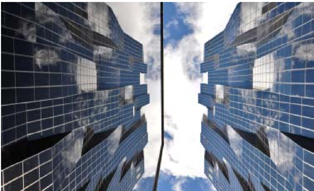
Il. 15. Nieregularna, schodkowa fasada DC Tower 1 i jej odbicie w elewacji budynku zlokalizowanego w miejscu planowanego DC Tower 2, będącego strefą wejściową do parkingu podziemnego (fot. Katarzyna Zawada-Pęgiel, stan z roku 2015).
