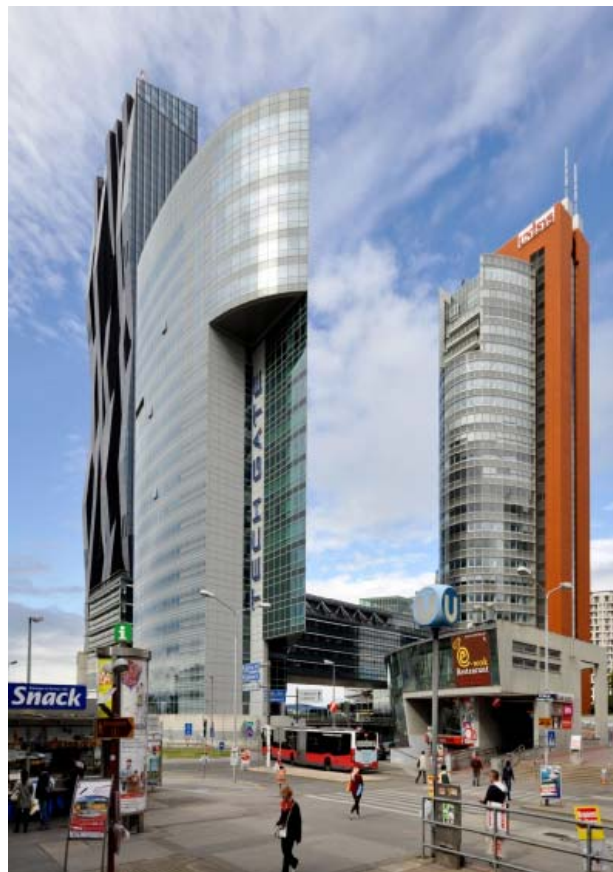
Il. 7. Park naukowo-technologiczny – Tech Gate Vienna projektu arch. Sepp Franka, Wilhelma Holzbauera, w bezpośrednim sąsiedztwie wieżowca Andromeda (po prawej) oraz DC Tower 1 (z tyłu po lewej) (fot. Katarzyna Zawada-Pęgiel, stan z roku 2015).
