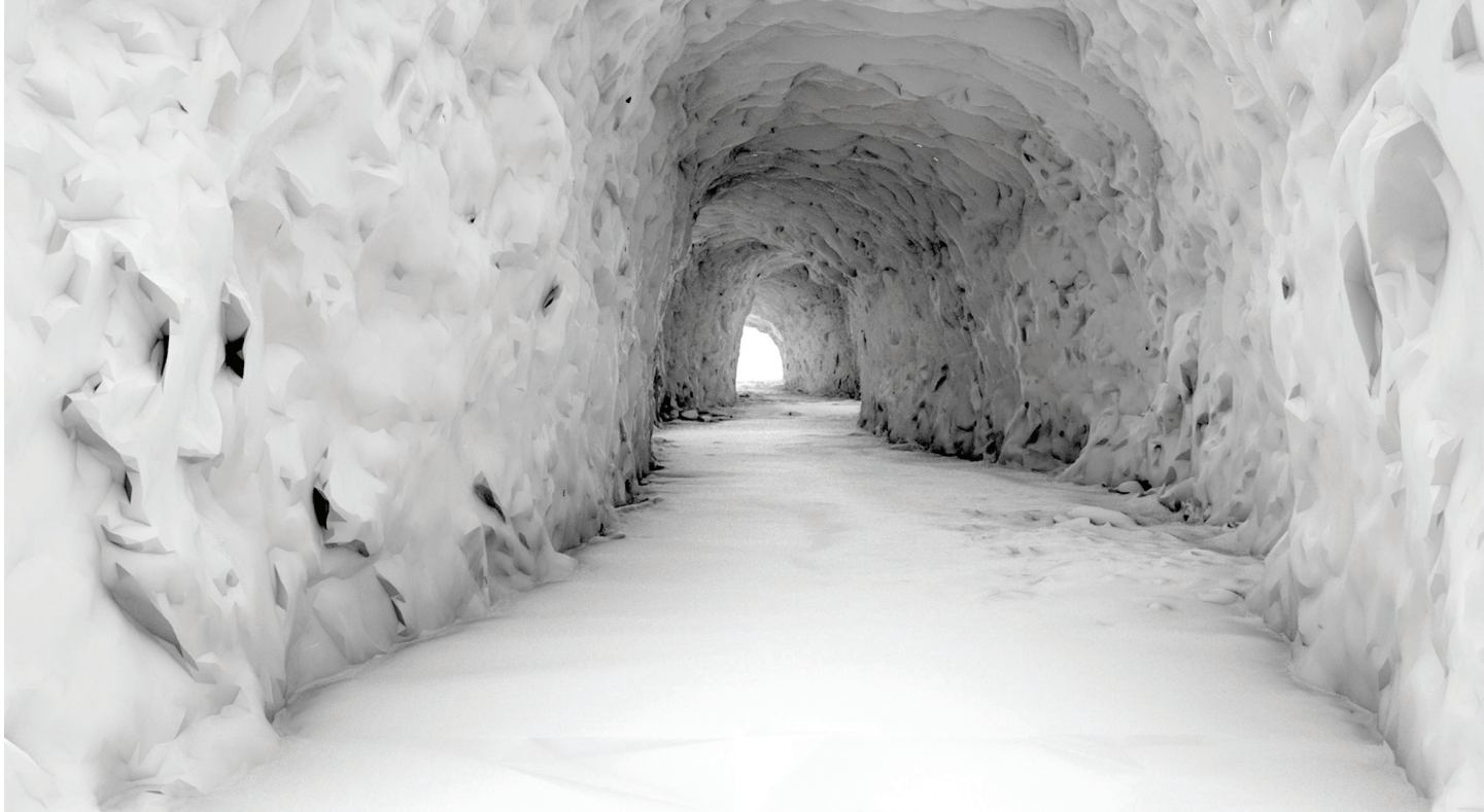
Fot. 6 Widok tunelu hydrotechnicznego z chropowatymi ścianami, badanego w ramach projektu Tunnelroughness
