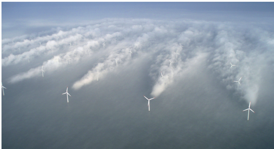
Rys. 3 Wizualizacja śladów za turbinami na skutek kondensacji w wilgotnym powietrzu. Farma Horns Rev
