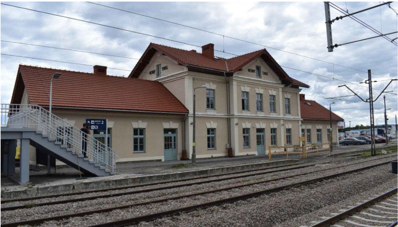
II. 2. Odnowiony dworzec kolejowy (obecnie także przystanek Podhalańskiej Kolei Aglomeracyjnej) w Nowym Targu, (fot. Ł. Bobek); https://gazetakrakowska.pl/nowy-targ-zakonczy-l-sie-remont-dworca-kolejowego-nowy-dworzec-robi-wrazenie/ar/c3-15068920 , (dostępne: 2.09.2021).
