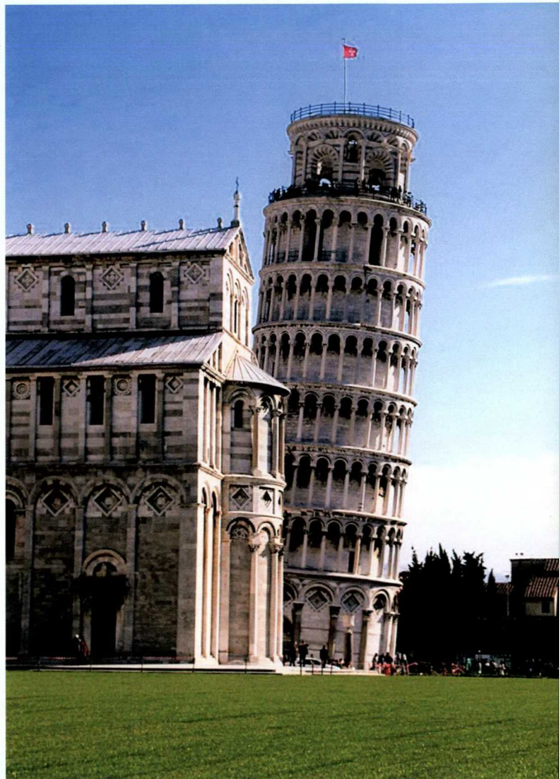
Słynna krzywa wieża w Pizie stanowi znakomity przykład zgubnego wpływu odkształceń podłoża na budowlę
