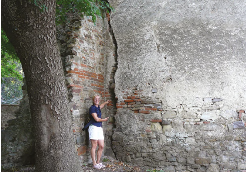
Abbildung 4. Risse vom Starkbeben 1590 an einem Turm der Tullner Stadtmauer (Foto: Roman Lahodynsky).
