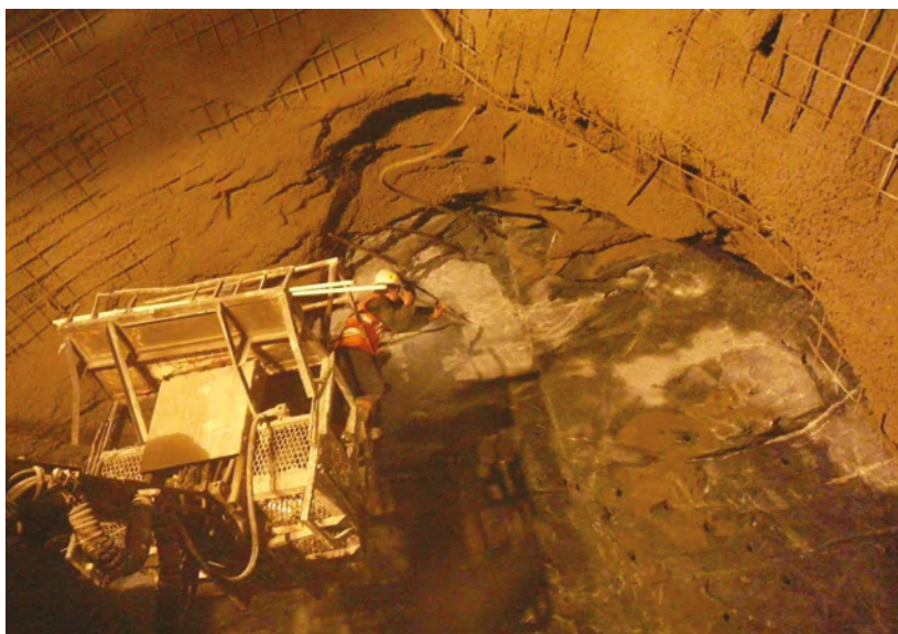
Abbildung 6. Lowari-Tunnel, Pakistan. Tunnelvortrieb nach der neuen österreichischen Tunnelbauweise (Foto: Roman Lahodynsky).
