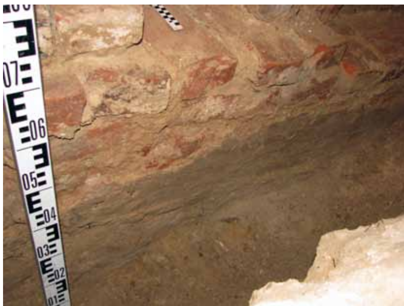
Il. 13. Zamek w Kórniku. Pomieszczenie 13, południowy fundament odkrytej konstrukcji murywanej. A – zachodnia partia fundamentu z odchodzącą przyporą – widok ze wschodu. B – pozostałości tynku na południowym licu fundamentu. Fot. Małgorzata Andrałojć
