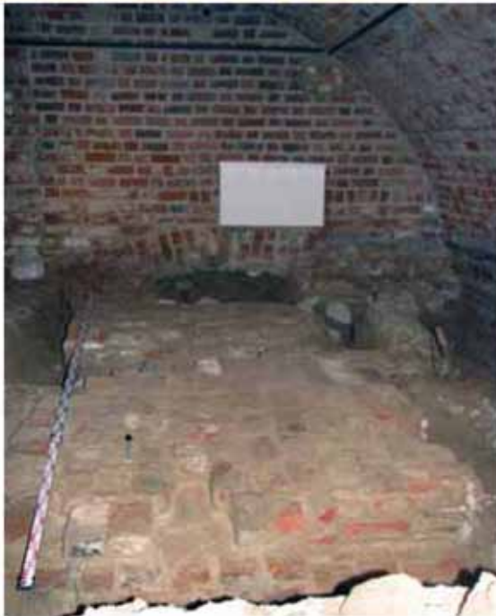
Il. 17. Zamek w Kórniku. Pomieszczenie 13 – elementy związane z ostatnią gotycką fazą przebudowy zamku. A – wkop fundamentowy w calowym piasku pod ścianę dzielącą pomieszczenia 13 i 20. B – łuk oporowy w dolnej części północnej ściany pomieszczenia nad fundamentem odkrytej konstrukcji murowanej. Fot. Małgorzata Andrałojć
