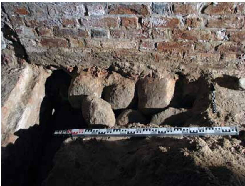
Il. 15. Zamek w Kórniku. Fundament z luźno ułożonych kamieni pod północną ścianą pomieszczenia 20. Po lewej przecinający go fundament odkrytej konstrukcji z ciągiem komunikacyjnym. Fot. Małgorzata Andrałojć
