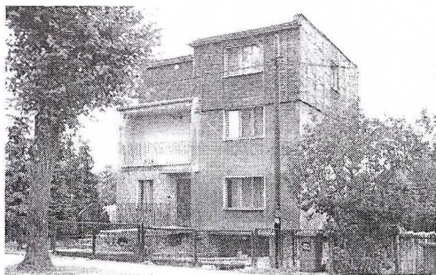
Fot. 12. Nadbudowa budynku mieszkalnego
