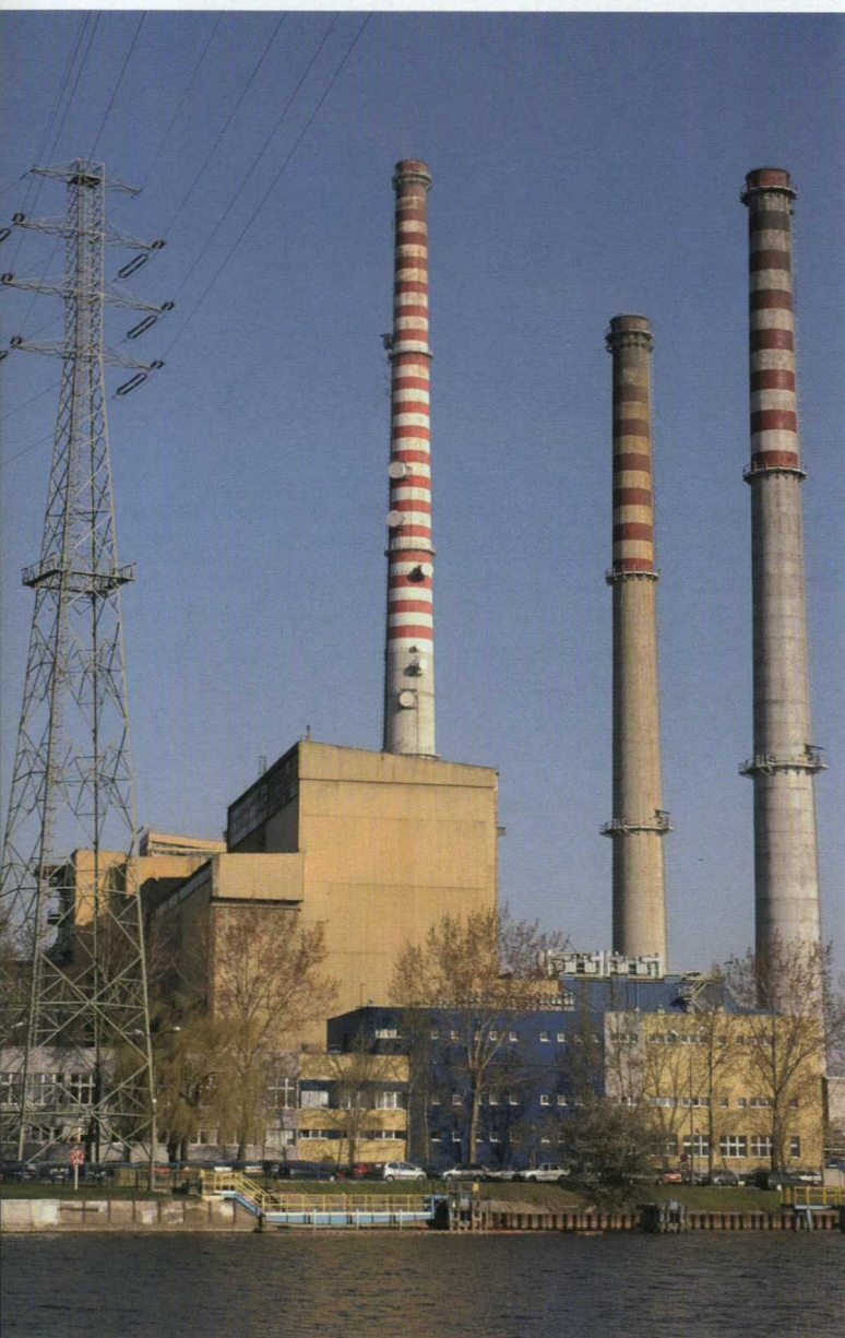
Skojarzone wytwarzanie ciepła i energii jest nie tylko wydajniejsze, ale i bardziej przyjazne dla środowiska. Na zdjęciu: Elektrociepłownia Gdańska
