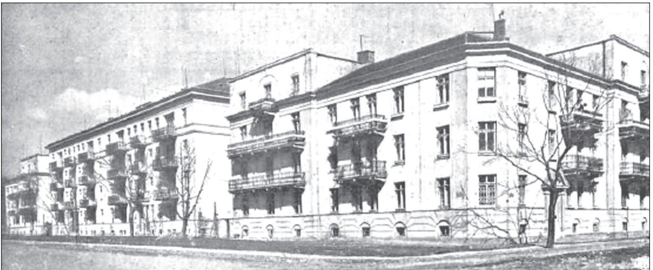
8. Widok na domy SBM „Ognisko” od ul. Topolowej i Wawelskiej, na planie z il. 4 zaznaczony numerem 3. Wg „Architektura i Budownictwo” („A i B”), 1929, nr 10, s. 371
