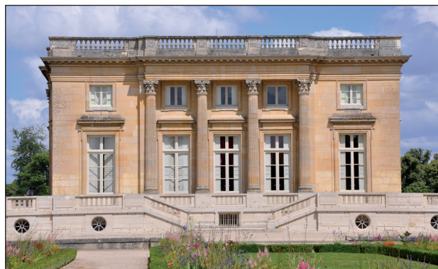
4. Petit Trianon, widok elewacji ogrodowej. Fot. Starus ( http://commons.wikipedia.org )
