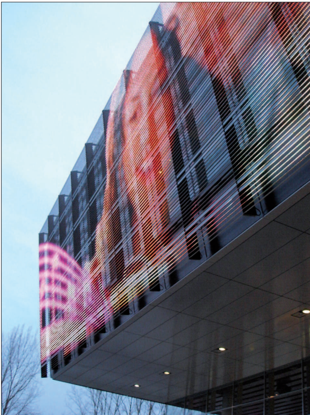
7. Symbolika | cechy powierzchni | pseudomobilność | elewacje medialne. Budynek biurowy T-Mobile, Bonn, arch. P. Schmitz, 2004. Fot. W. Celadyn
