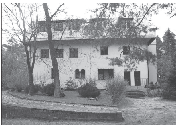
9. Widok budynku przy ul. Myśliwskiej 2 od strony północnej. Fot. A. Dymek, 2012 9. North view of the Myśliwska 2 building. Photo A. Dymek 2012
