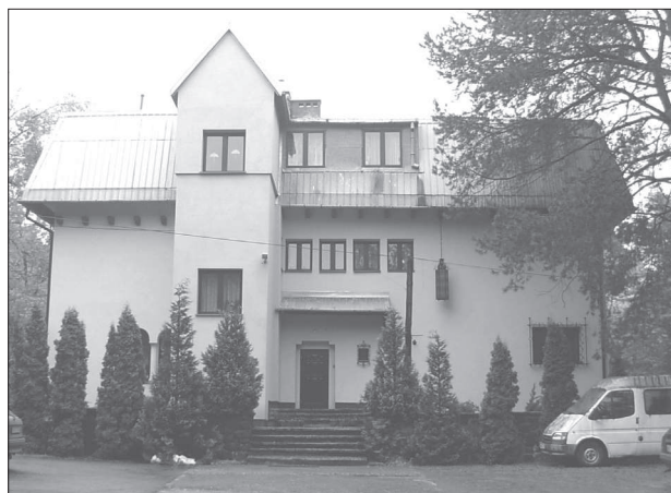
8. Elewacja frontowa (zachodnia) budynku przy ul. Myśliwskiej 2. Fot. A. Dymek, 2009 8. Front (west) elevation of the Myśliwska 2 building. Photo A. Dymek 2009
