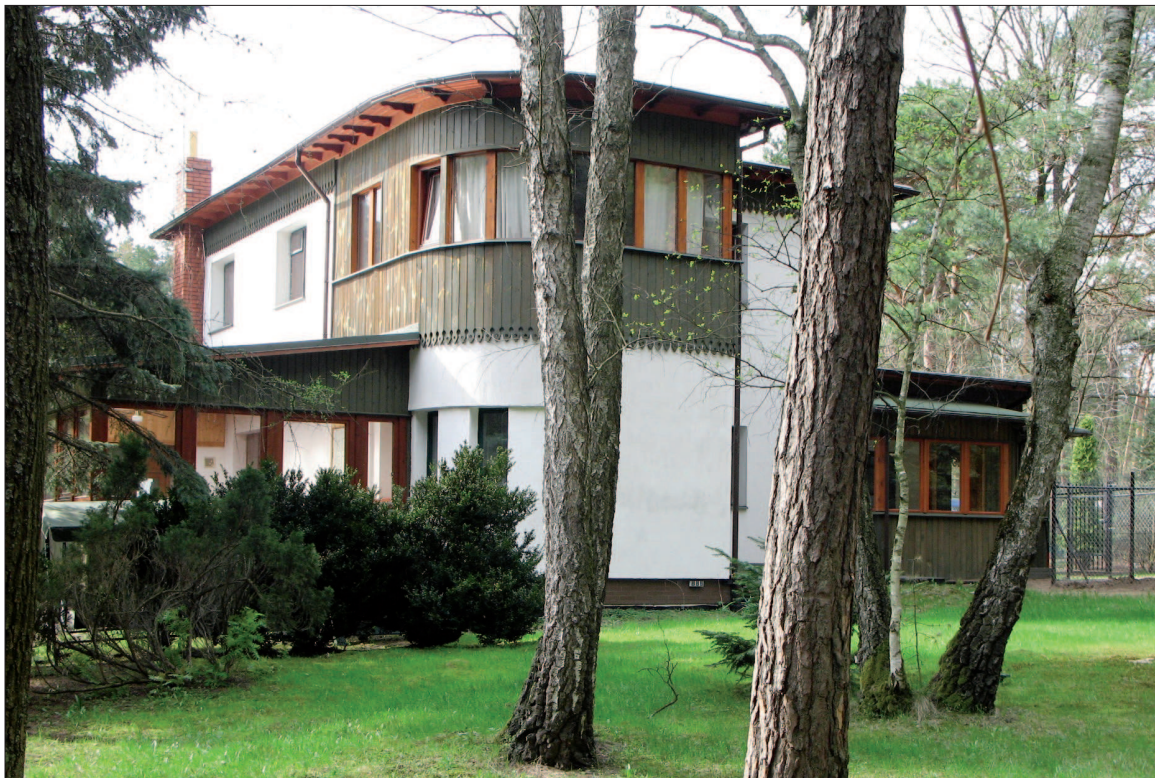
22. Widok budynku przy ul. Lipowej 2. Fot. A. Dymek, 2012 22. View of the Lipowa 2 building. Photo A. Dymek 2012
