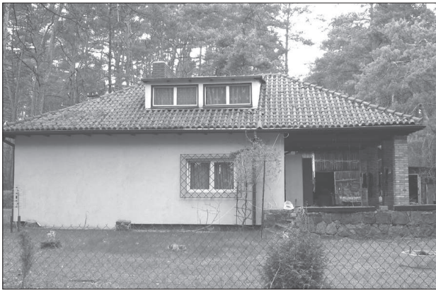
19. Elewacja boczna budynku przy ul. Redutowej 39.
