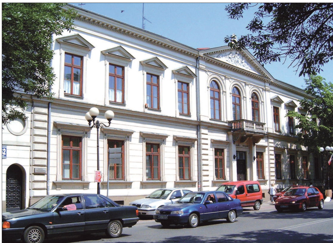
15. Budynek Towarzystwa Kredytowego Ziemskiego w Siedlcach, wzniesiony przez Juliana Ankiewicza w 1872, fot. I. Szustakiewicz 2007
