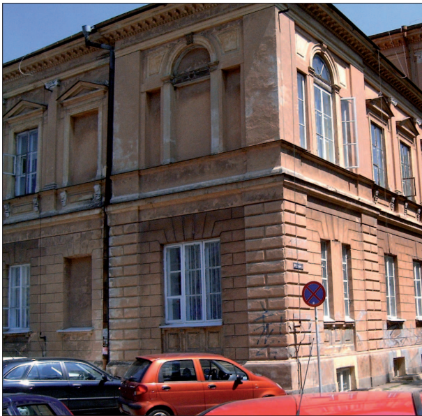
10. Lublin, dawny budynek Rządu Gubernialnego w Lublinie, wzniesiony przez Juliana Ankiewicza w latach 1859-1860, fragment elewacji z serlianą, fot. I. Szustakiewicz, 2008 10. Lublin, former Provincial Government building in Lublin, erected to the design of Julian Ankiewicz in the years 1859-1860, fragment of the façade with a Palladian window, photo by I. Szustakiewicz, 2008
