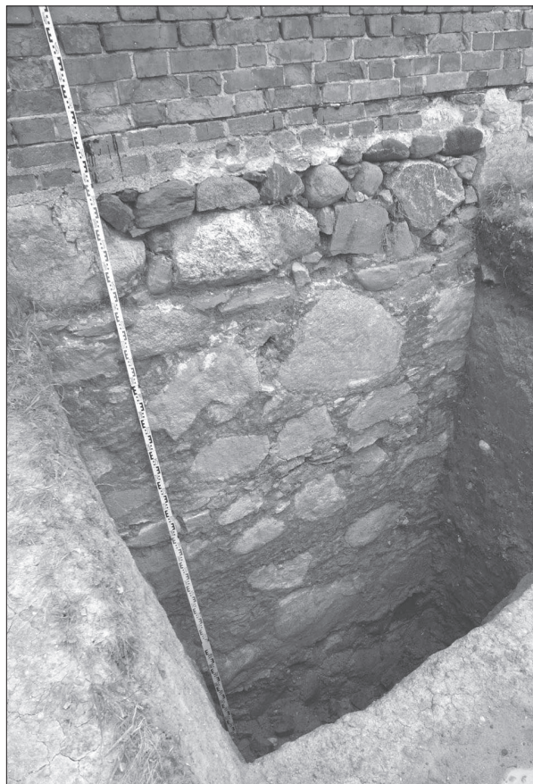
18. Radzyń Chełmiński. Skrzydło zachodnie zamku. Widok lica fundamentu muru zachodniego skrzydła zachodniego zamku, fot. M. Wiewióra
