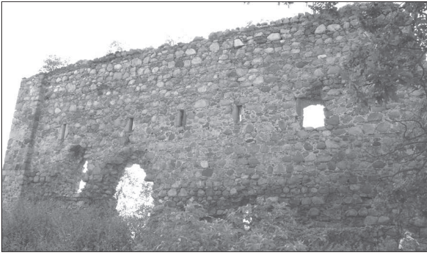
4. Papowo Biskupie. Widok elewacji skrzydła wschodniego zamku, fot. M. Wiewióra 4. Papowo Biskupie. Elevation view of the east wing of the castle, photo: M. Wiewióra
