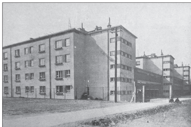
5. Widok na bloki przy ul. Stanisławowskiej od strony pionów mieszczących pralnie i suszarnie. Źródło: T.O.R. Sprawozdanie (...) za rok 1938, Warszawa 1939
