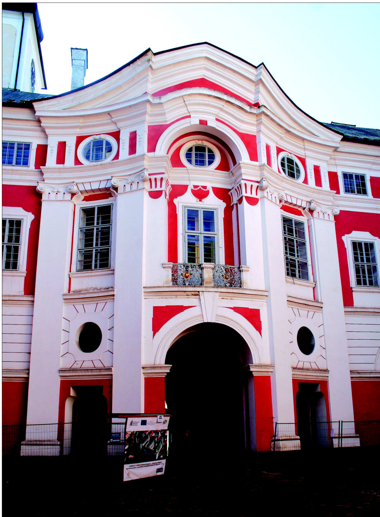
8. Ryzalit skrzydła klasztoru w Broumowie. Fot. aut. 2014 8. The projection of the monastery of Broumov. Photo: the author 2014
