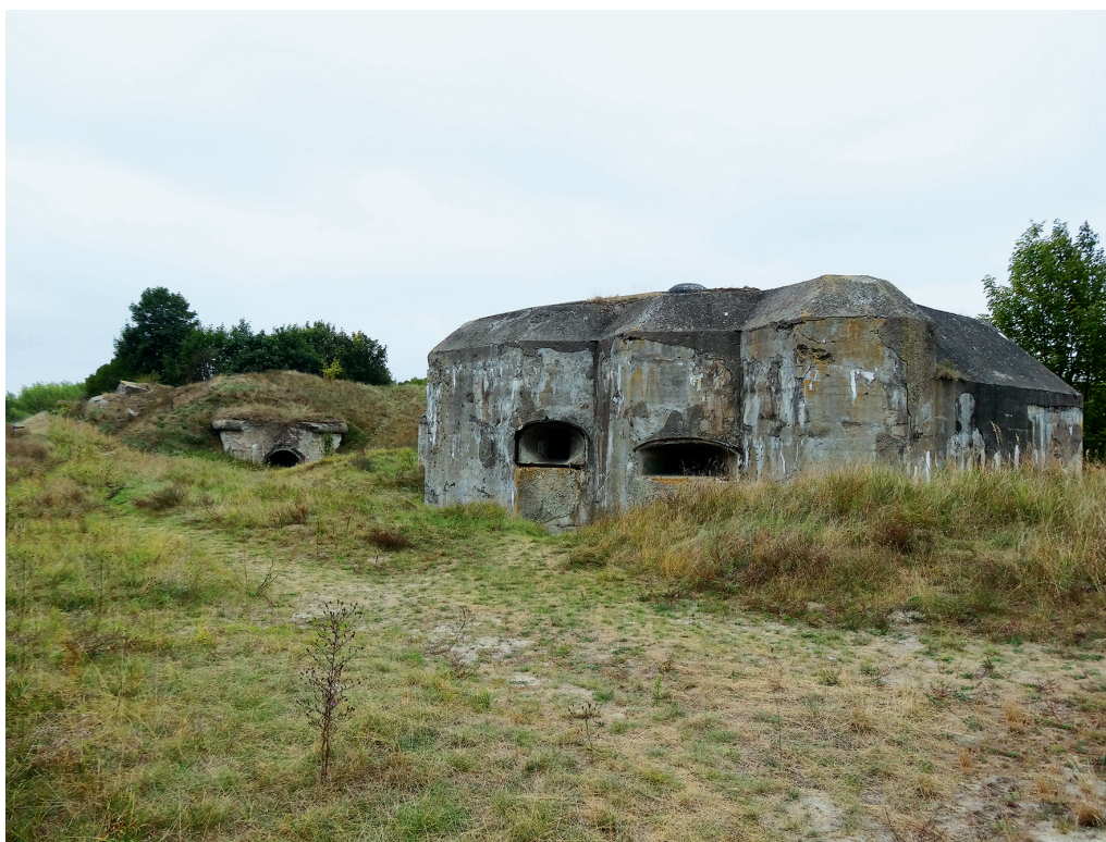
10. Twierdza Osowiec, Fort II (Zarzeczny), 1912–1914, betonowy tradytor. Fot. C. Głuszek, 2014
