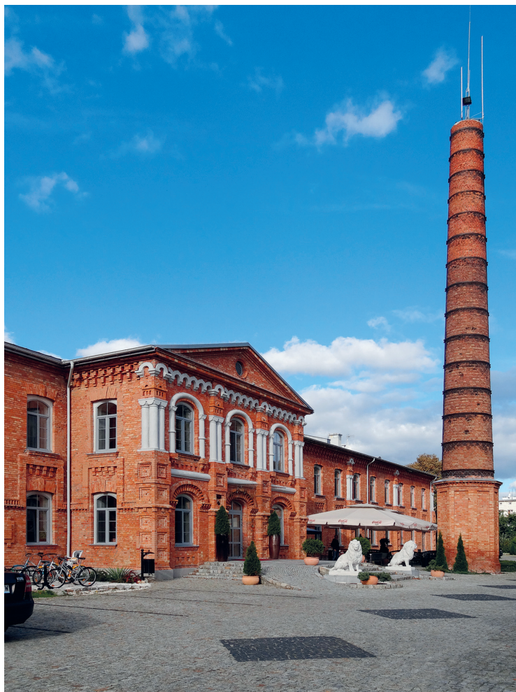
6. Twierdza Modlin, pralnia na zewnętrznym obwodzie cytadeli, ok. 1900; obecnie hotel. Fot. C. Głuszek, 2013
