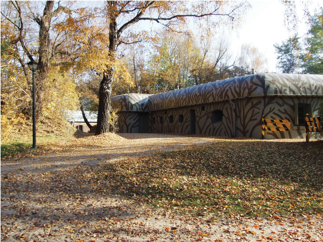
3. Twierdza Kraków, fort pancerny „Grębałów” (1897–1899), tradytor z przywróconym na podstawie badań konserwatorskich kamuflażem. Fot. J. Janczykowski, listopad 2011
