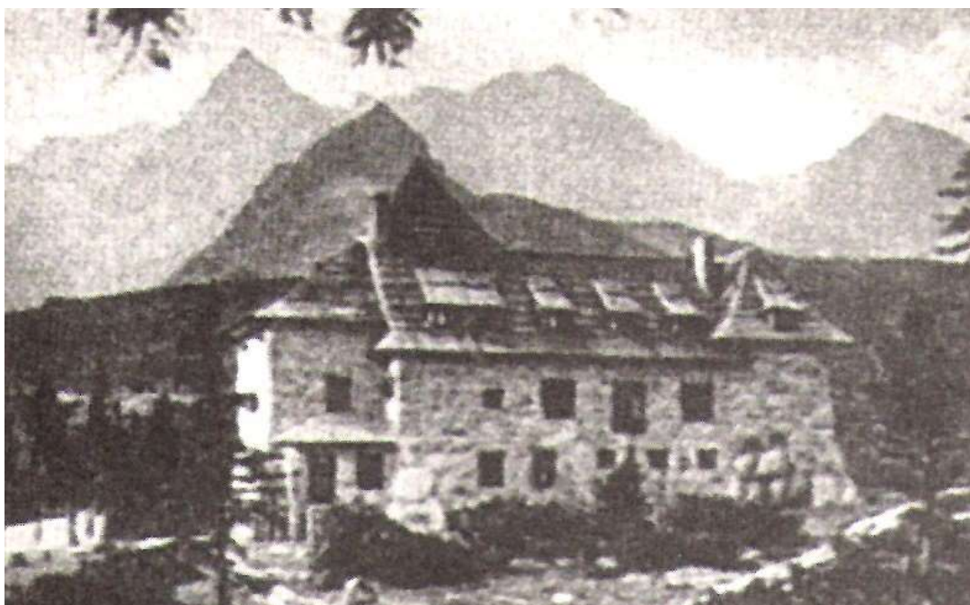
II. 3. Tatry Polskie. Hala Gąsienicowa. Schronisko „Murowaniec”. Elewacja północna, w tle Kościelec i Świnica. Sylweta schroniska harmonizuje z trójkątnymi szczytami Kościelców. Źródło: Budowa terenów i urządzeń sportowych, Warszawa 1928, s. 332
