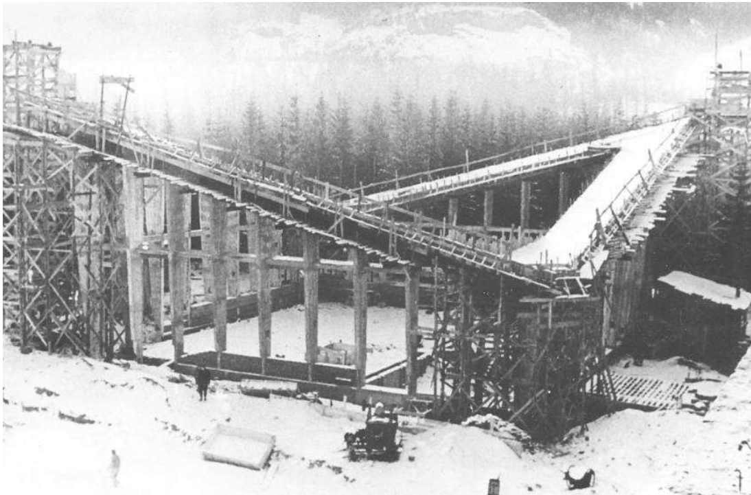
Il. 24. Andrzej Skoczek. Hala sportowa w Zakopanem w budowie.
