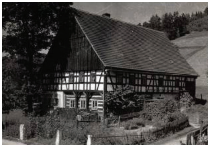
Ryc. 10. Wojcieszycze (pow. jeleniogórski), stromy dach nad budynkiem o konstrukcji przysłupowo-wieńcowo-ryglowej, stan budynku przed remontem. http://wroclaw.hydral.com.pl/photo.action?view=&id=808924 , dostęp: 13.08.2012.
