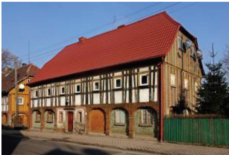
Ryc. 9. Bogatynia (pow. zgorzelecki), piętrowy budynek z konstrukcją przysłupową parteru i ryglową piętra, z krótkimi łukowymi mieczami
