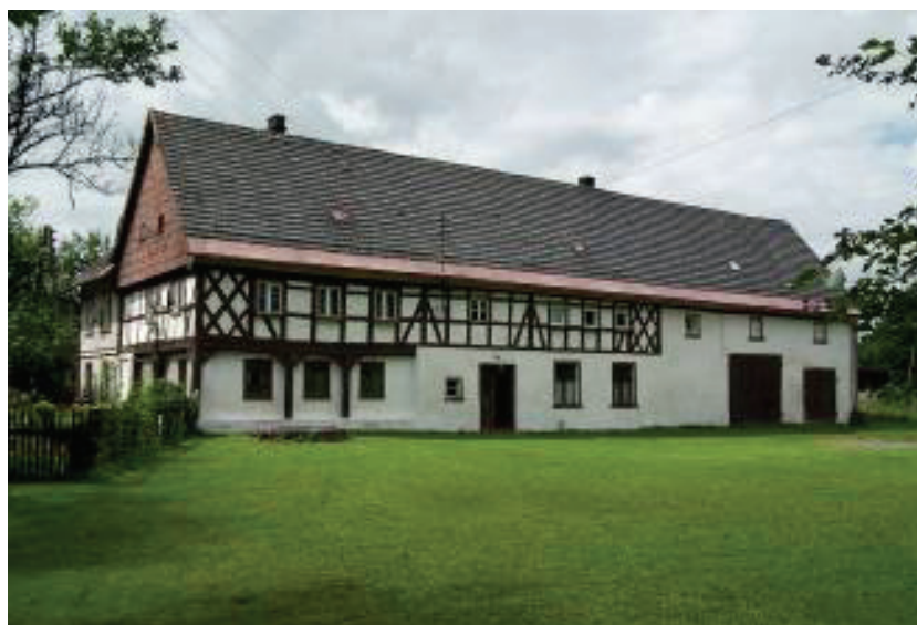
Ryc. 7. Stara Kamienica (pow. jeleniogórski), piętrowy dom o konstrukcji przysłupowo-ryglowej. http://wroclaw.hydral.com.pl/photo.action?view=&id=962148&idEntity=561382 , dostęp: 13.08.2012
