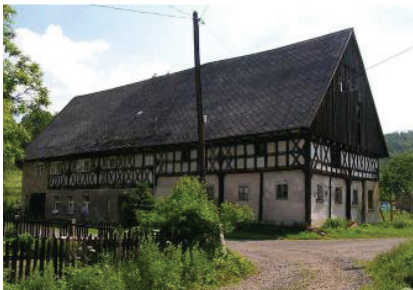
Ryc. 8. Gruszków (pow. jeleniogórski), piętrowy dom o konstrukcji przysłupowo-ryglowej. http://wroclaw.hydral.com.pl/photo.action?view=&id=664413&idEntity=520272 , dostęp: 13.08.2012
