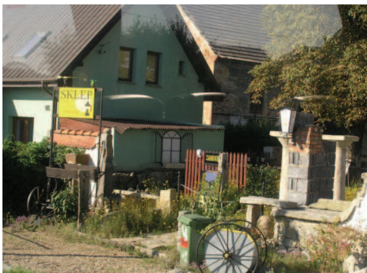
Ryc. 3. Wprowadzanie rustykalnych elementów nieco obcych istniejącej architekturze (fot. autor 2010)
