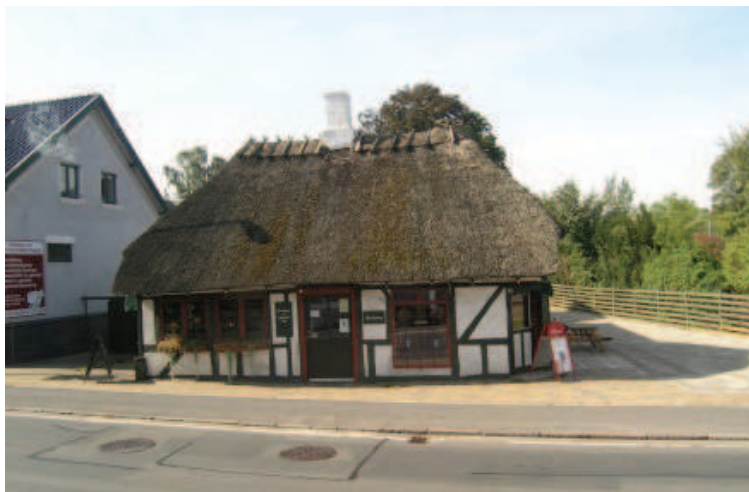
Ryc. 1. Kontrastowe sąsiedztwo stylów architektonicznych (fot. autor 2010)
