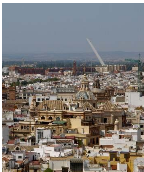
Ryc. 4 C. Wyróżniający się w panoramie Sewilli pochylony biały pylon mostu Alamillo, łączącego miasto z wyspą Isla de la Cartuja – terenem Expo'92. Fot. I. Sykta
