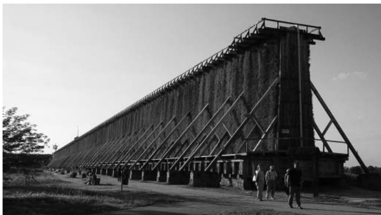
Fot. 1. Teżnie solankowe w Ciechocinku, wybudowane w latach 20. XIX w. Konstrukcja teźni była wzniesiona na potrzeby warzelni soli działającej w tym miejscu od 1830 r. Współcześnie obiekt pełni funkcję uzdrowiskową.
