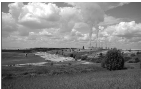
Fot. 7. Składowisko popiołów dla Elektrowni Belchatów na zwałowisku wewnętrznym Pola Belchatów
