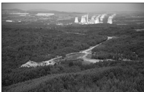
Fot. 2. Panorama zwałowiska zewnętrznego w kopalni Turów
