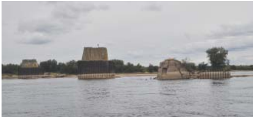
g) Pozostałości mostu Opalenie
