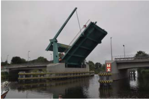
a) Most drogowy w Drewnicy
