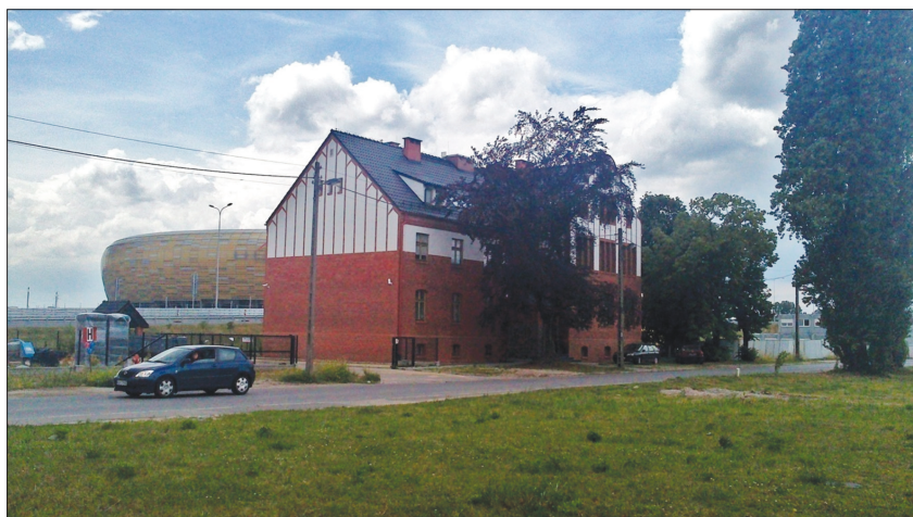
Fot. 9. Wyremontowany budynek szkolny przy ul. Uczniowskiej – w tle stadion PGE Arena Gdańsk (stan na 14.07.2014)
