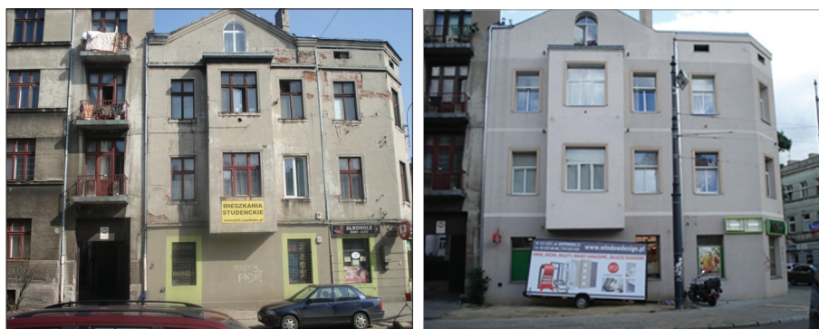
Fot. 4. Prywatna kamienica przeznaczona dla studentów przed i po remoncie
