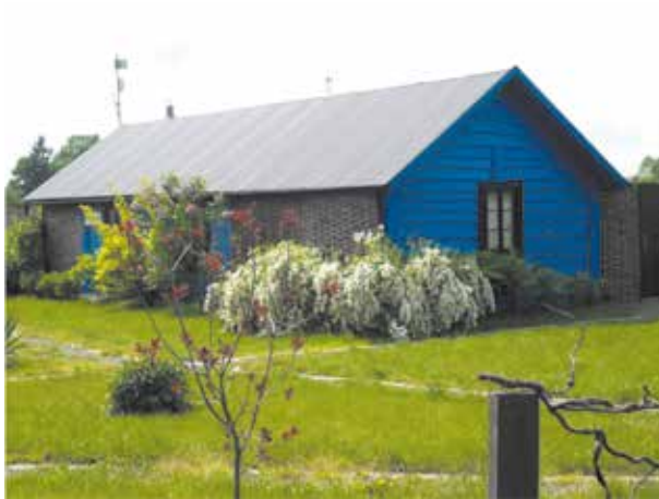
Fot. 1. Jeden z budynków miniośrodka „Nadbużańska cisza” Źródło: M. Wesołowska (fot. 1–3).
